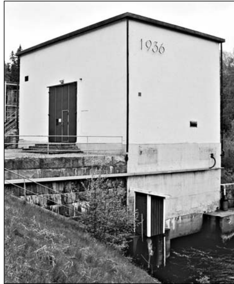
Värmeshults kraftstation i Gällaryd, invigd 1936
